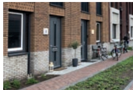
Doorlopende plint in de Spoorstraat
