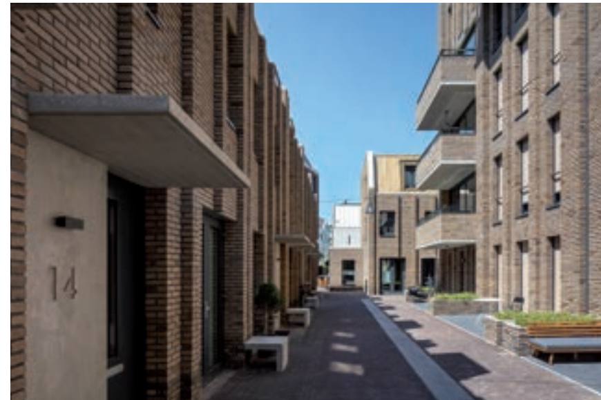
Harde overgang met geïntegreerde bankjes en plantenbakken in tussenstraat Metawa ensemble
