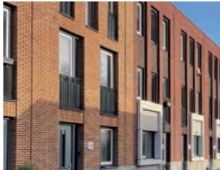
Verticale geleiding in de gevel
