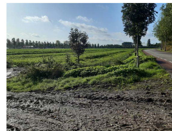
De bestaande brede duiker naar het perceel toe, het plangebied ligt lager dan de Lingeweg
