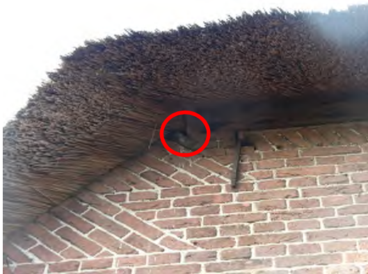
Afbeelding 3.10. Een van de nestlocaties van de huismus in de woning aan de Medelsestraat 18.
