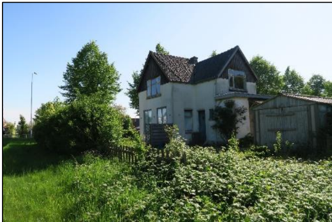
Foto 1. Te slopen woning met bijgebouw en de te verwijderen vegetatie in het plangebied
