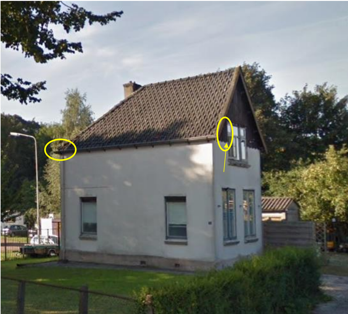
Foto 1. Locaties (gele cirkels) zomerverblijfplaatsen gewone dwergvleermuizen aan de Lingedijk 3 te Tiel
