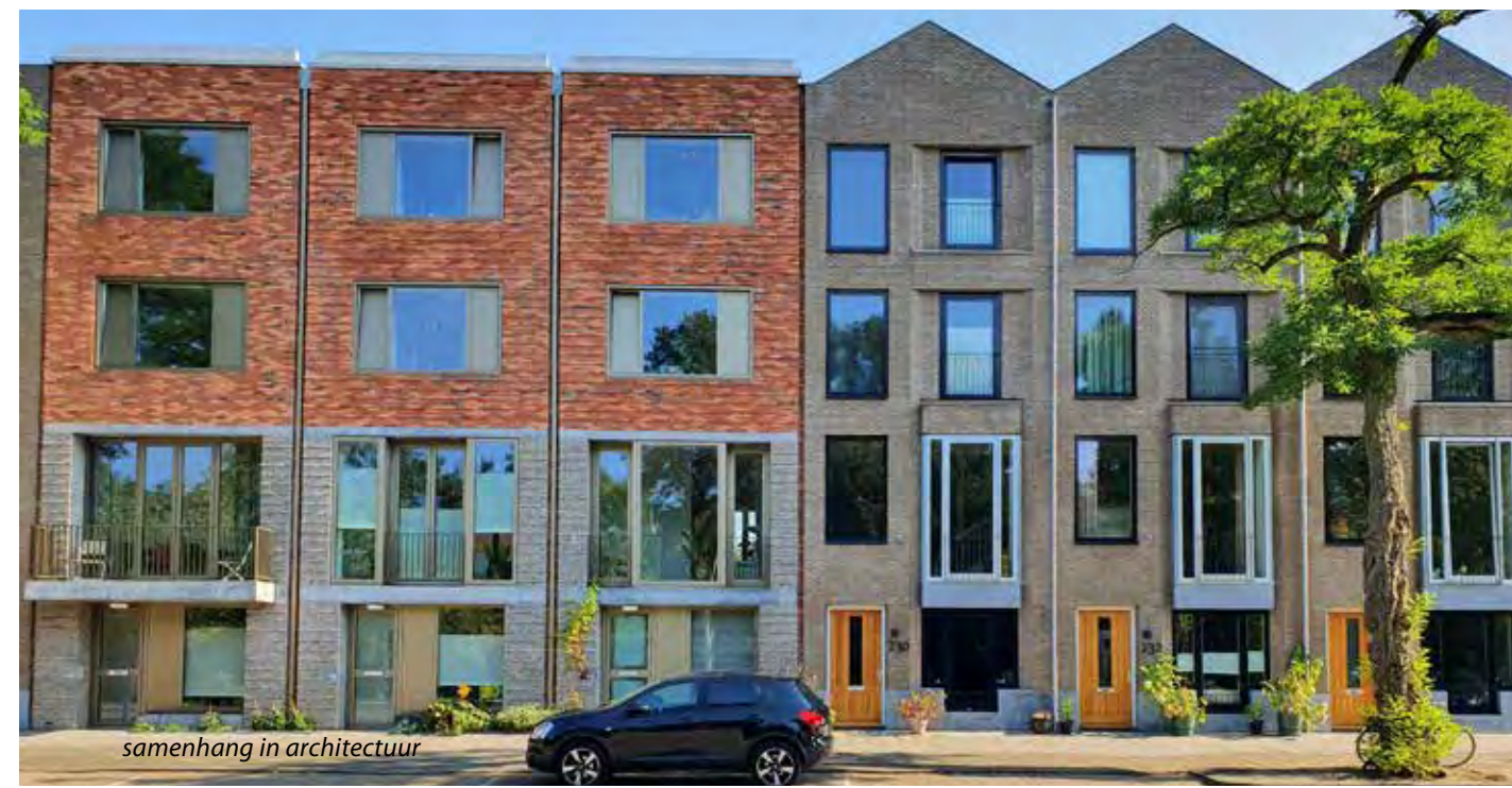
Aansluiten op bestaande 2x1 kap- en vrijstaande woningen
