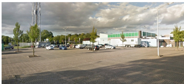
Het grote parkeerterrein aan de Westzijde van het complex
